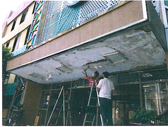
校門口天花板老舊剝離、鋼筋鏽蝕等修復完成
